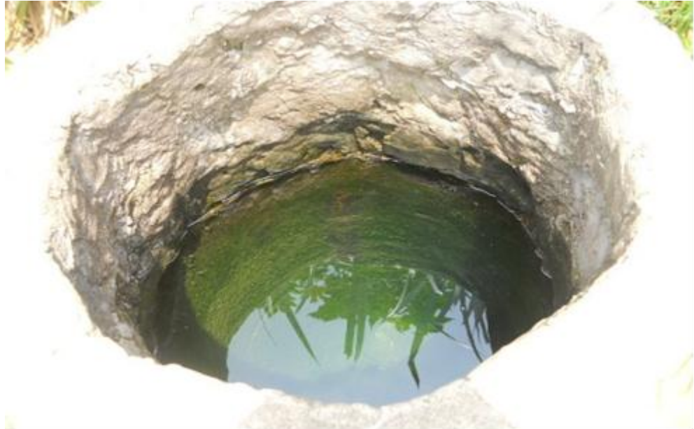
Figura 2-10 Poço de água no distrito de KaNyaka
