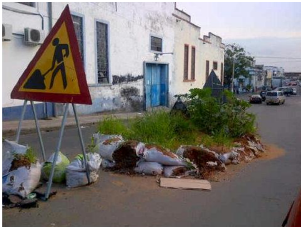
Figura 3-11 Estrada em obras Av. Mahomed Siad Barre, bairro do Alto Maé, distrito de KaMpfumu
