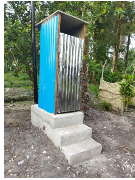
Figure 25 In Bonthé, die fertigen Toiletten
